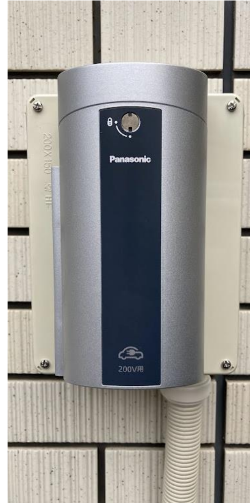
EVコンセント (3kw)
